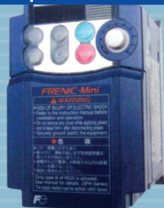
VVVF: FUJI - JAPAN (Nhật Bản) (Biến tần cửa: Điều chỉnh đóng mở cửa êm ái)
